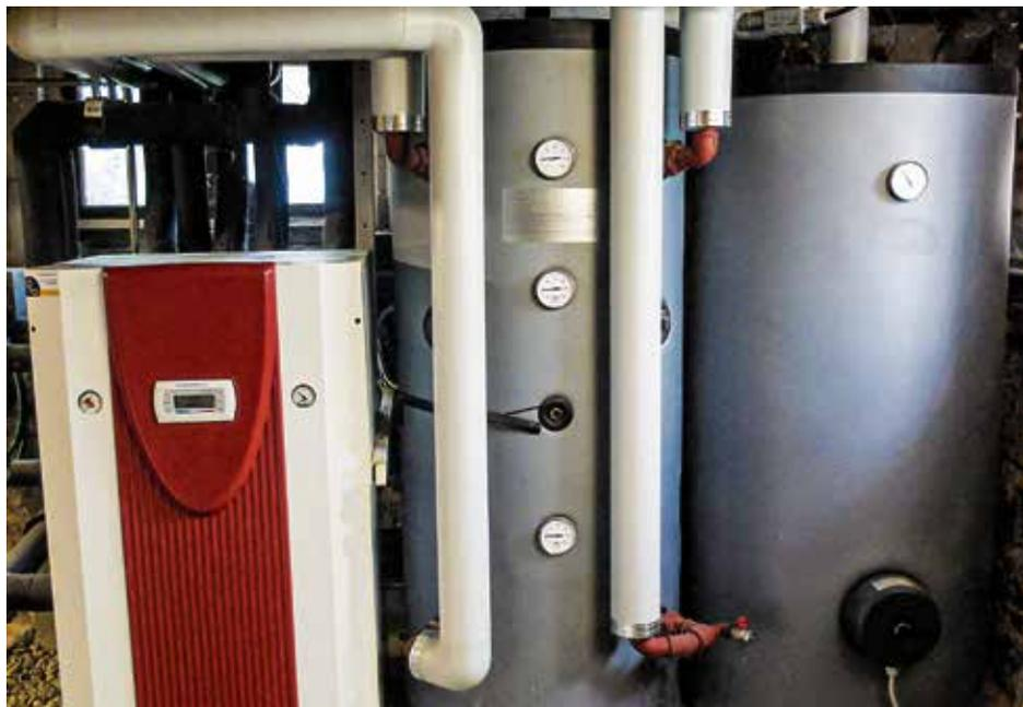
Der Heizungsersatz bietet die Chance, auf erneuerbare Energien umzusteigen. Eine Wärmepumpe (Bild) lohnt sich gegenüber einer Öl- oder Gasheizung. Foto: pd.
