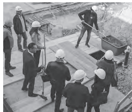
Im Bau: Wohnbaupartner relesta realisiert an zentraler und ruhiger Lage in Romanshorn Kauf- und Mietwohnungen. Foto: Markus Bösch
