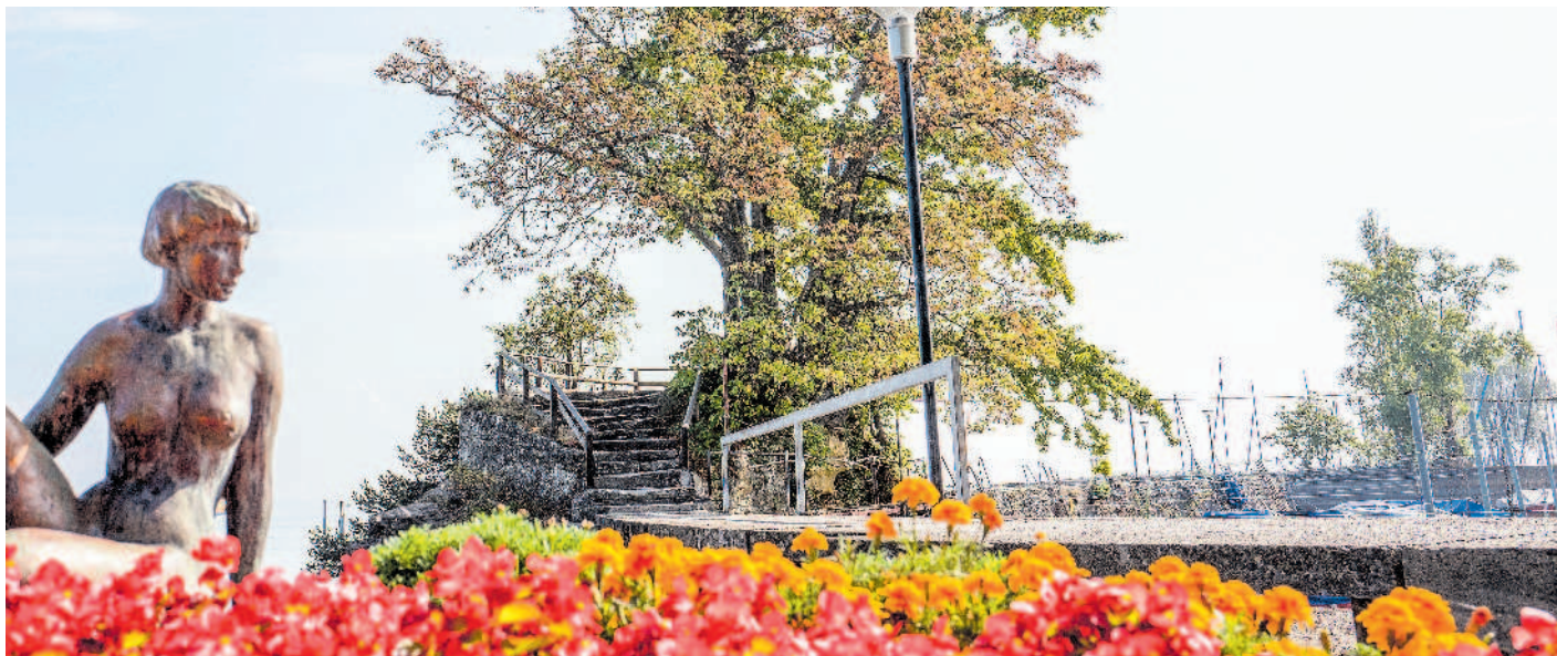
Teil der projektierten Ufersanierung: Das «Inseli» beim Seepark.
