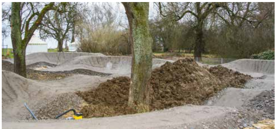
Kleiner Track fertig gebaut.
