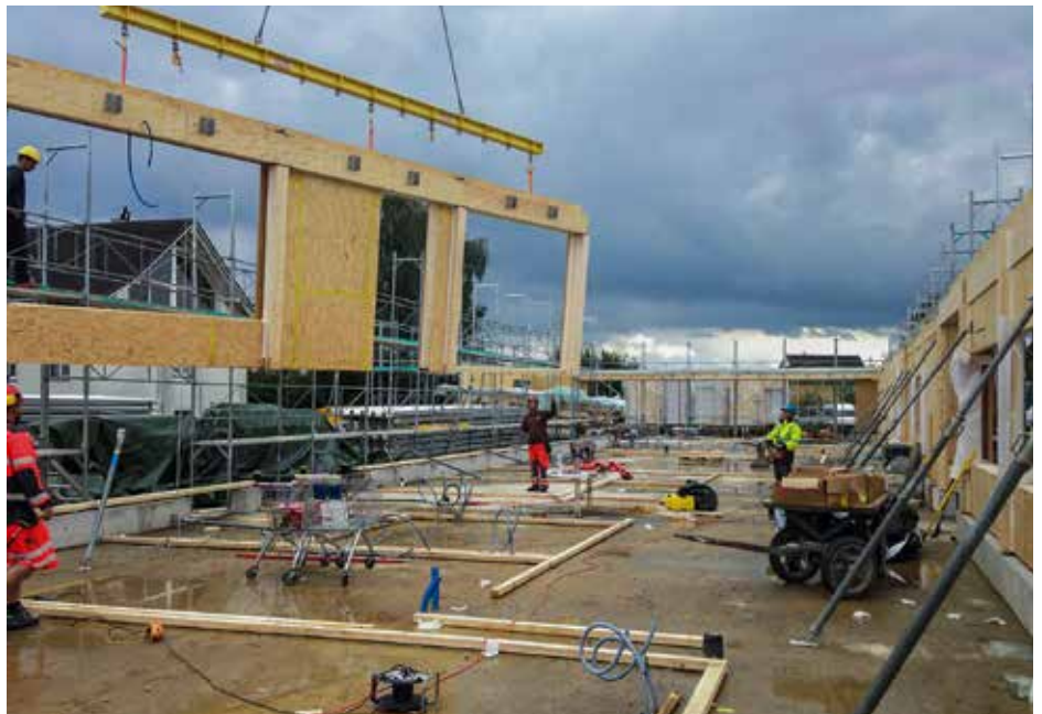
Das neue Quartiersschulhaus im Grund der Primarschule nimmt Form an.
