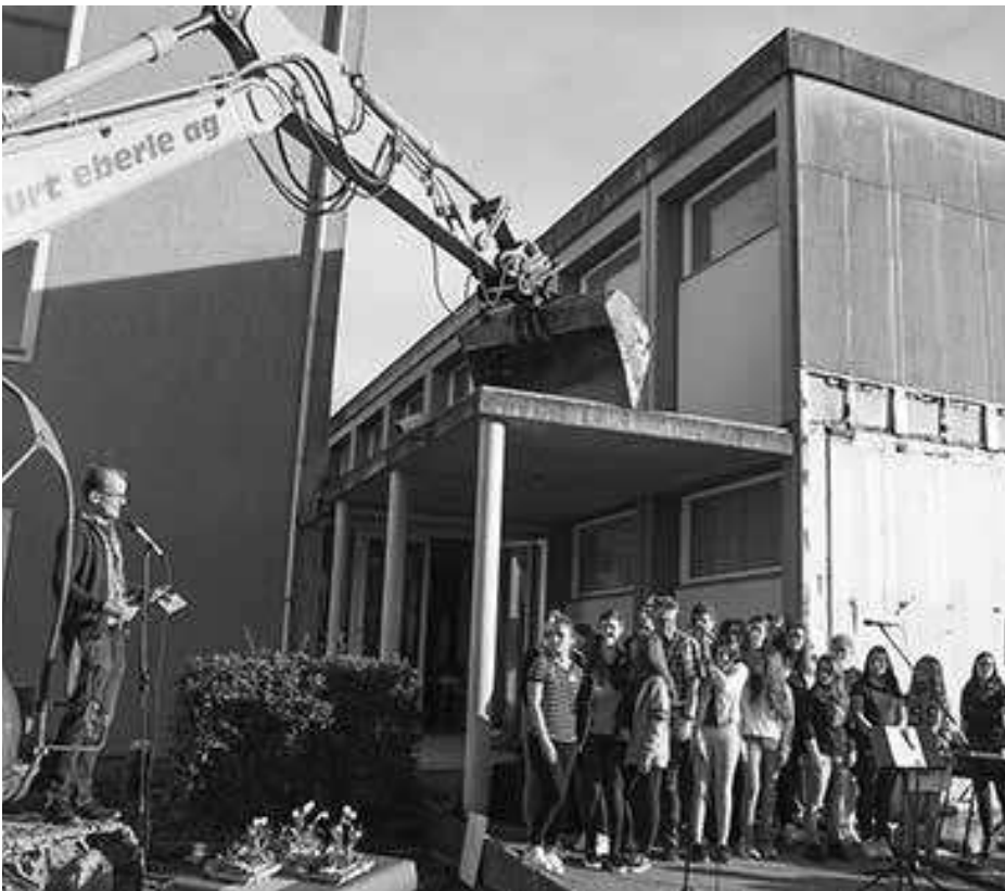
Sek-Präsident Walo Bohl freut sich über den baldigen Baubeginn.
