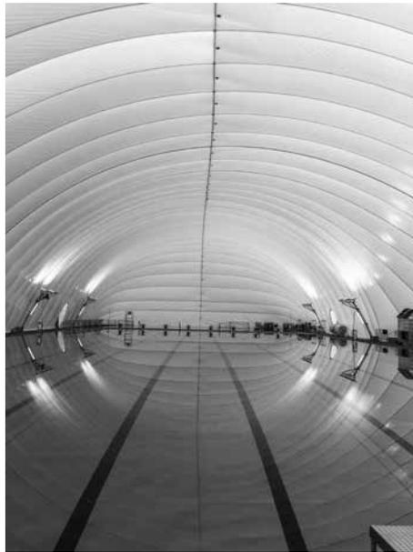
*Das Innenleben einer Traglufthalle (hier Lugano): Lichttransparenz mit LED Beleuchtungen und Lüftung rechts.*
