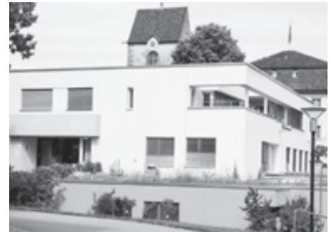
Veränderung: Es ist geplant, auf dem Dach des Pfarreiheims eine Fotovoltaikanlage zu installieren – ganz im Sinn des Umweltlabels «Grüner Güggel». (Bild: Markus Bösch)
