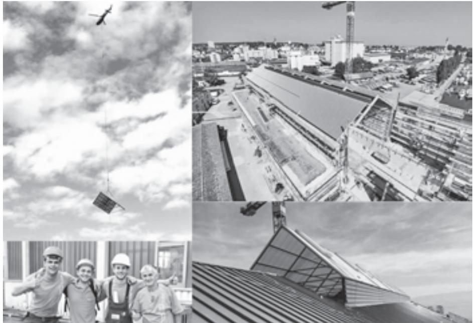
am See geflogen. Die Kuppen wurden auf dem Nebendach deponiert und werden im Anschluss mit dem Baukran millimetergenau auf die vormontierte Montagestelle gehievt und durch die schwindelfreien Mon-
