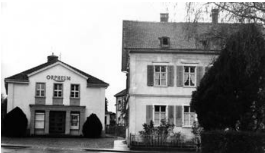
Kino Orpheum, erbaut 1920, wird heute als Jugendtreff genutzt. Die Baute rechts musste 1960 dem Erweiterungsbau (heute Kino «Roxy») weichen.
