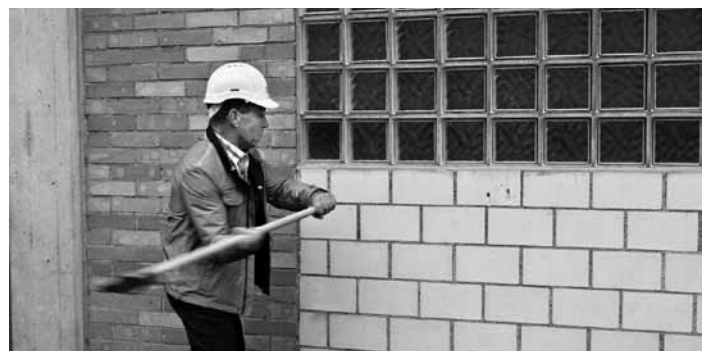
Peter Sidler schlägt symbolisch ein Loch ins Gemäuer der alten Fabrikhalle an der Hofstrasse in Romanshorn. Hier entstehen zwei neue Werkhallen für Produktion und Lager der SIDLER Metwallwaren AG.
