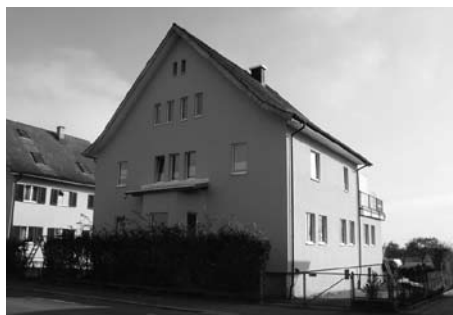
Sanierung Wohnhaus Amriswilerstrasse 19
