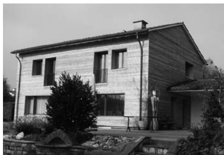
Sanierung Wohnhaus Heimatstrasse 10
