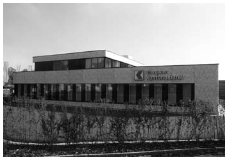
Fassadensanierung TKB-Gebäude Bahnhofstrasse 54a
