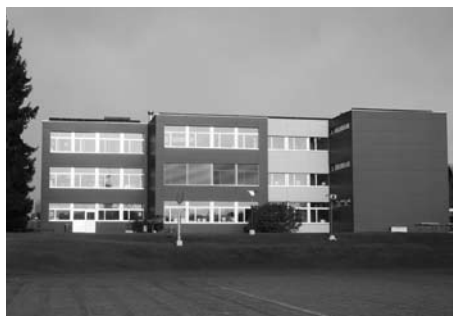
Fassadensanierung und Fotovoltaikanlage Schulanlage Reckholdern
