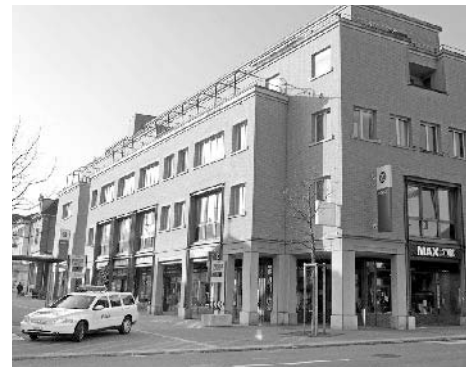
Der neue Kantonspolizeiposten Romanshorn wird am 5. März 2008 eröffnet.
