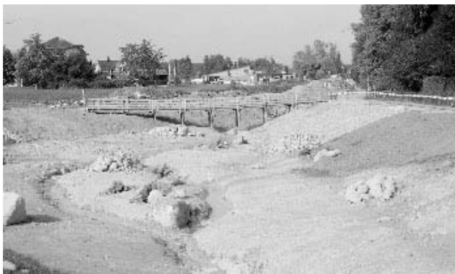
Das Rückhaltebecken Radwäg kann rund 5000 m 3 Wasser zurückhalten und spielt eine wichtige Rolle in Bezug auf den Hochwasserschutz für das Zentrum von Romanshorn.
