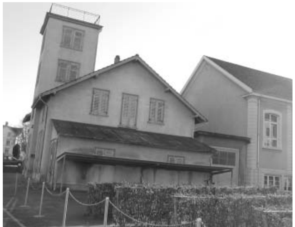
Mit einem alten Gebäude in die Zukunft: Das alte Feuerwehr-Depot kann in eine moderne Primarschul-Aula umgebaut werden. (Bild: Markus Bösch)
