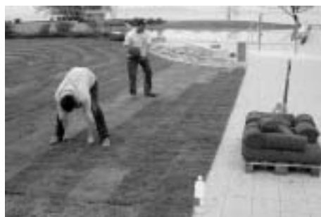
Verlegen des Rasenteppichs
