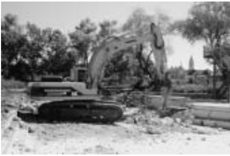
Abbruch des alten Rutschbahnbeckens
