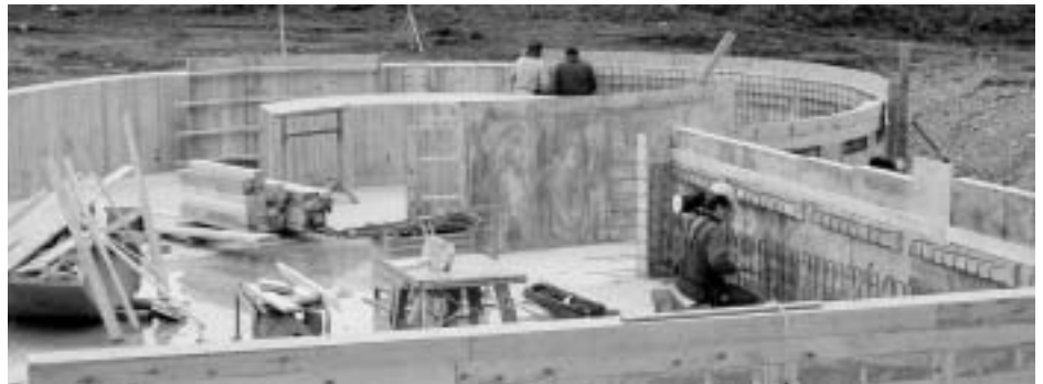
Betonierung des neuen Erlebnisbeckens
